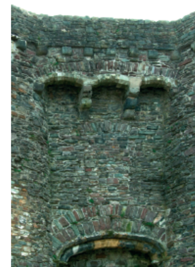
Yn edrych i fyny at fynedfa'r porthdy. Y rhyngdyllau arllwys yw'r bwâu cain o garreg Caer Faddon sydd wedi eu corbelu rhwng y ddau dŵr ar lefel y llawr cyntaf a'r parapet.
