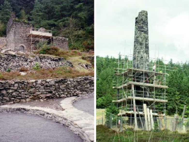
Gwaith atgyfnerthu Ystrad Einon (G. Levins) Gwaith cadwraeth yn digwydd ar Simnai Cwmsymlog (S. Hughes) Consolidation work at Ystrad Einon (G. Levins) Conservation work being undertaken on Cwmsymlog Chimney (S. Hughes)
