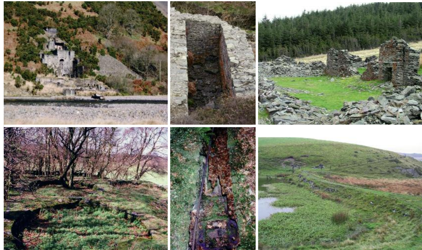
O'r pen i'r gwaelod yn null cloc: Y gwaith malu mwyn yng Ngwaith Coch, wedi'i drefnu ar wahanol lefelau ar lethr y bryn. Mae maint y gwastraff a daflwyd yn egluro'r broses o baratoi mwyn, o dalpiau mawr ar ben y safle i laid tenau ar y gwaelod. Tomenni sbwriel o wastraff prosesu mwyn. Adfeilion swyddfeydd mwyngloddio yn Esgair Hir. Cronfa ar gyfer cadw dŵr gynt. 'Pwll olwyn'. 'Rhodenni fflat' i drosglwyddo ynni o olwynion dŵr i beiriannau arall. Pyllau cerwyn. (G. Levins)
